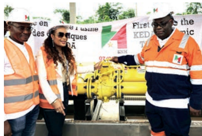
Cap sur la livraison de gaz à une usine de fabrication de carreaux construite à Kribi
